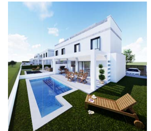
VISTA POSTERIOR VIVIENDA
